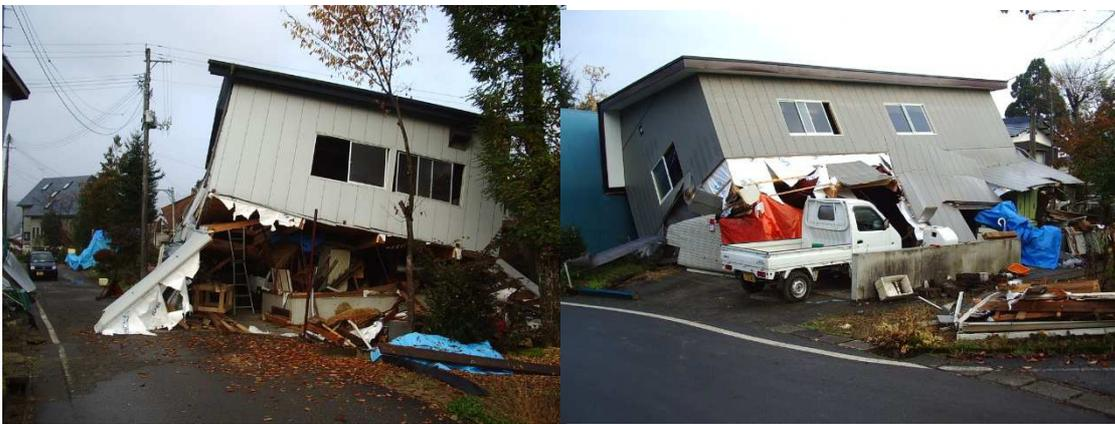
田麦山地区、新耐震木造住宅倒壊事例 Z金物なし
